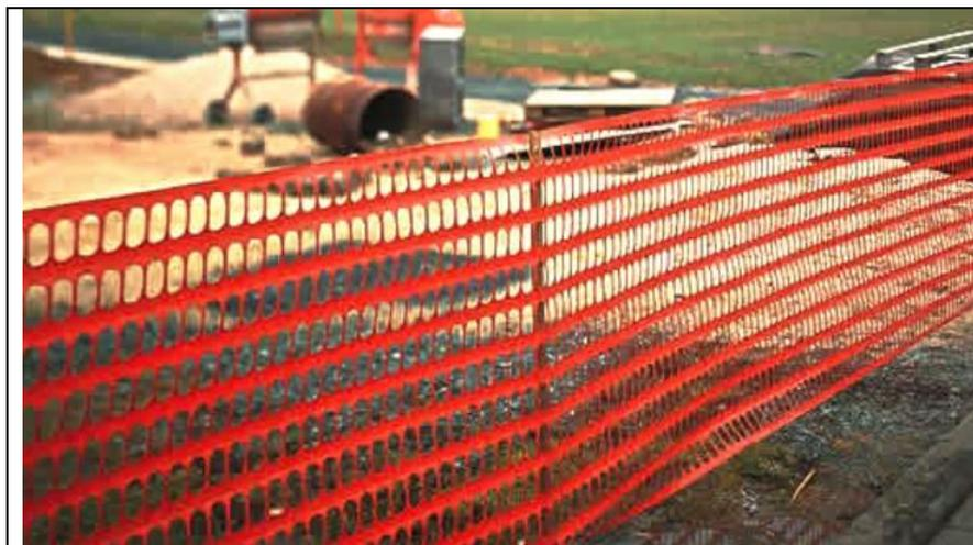
Сигнальная сетка применяется в случае отсутствия перепада (например, если траншея закрыта досками и отсутствует риск падения в траншею можно оградить строительный участок сигнальной сеткой)
