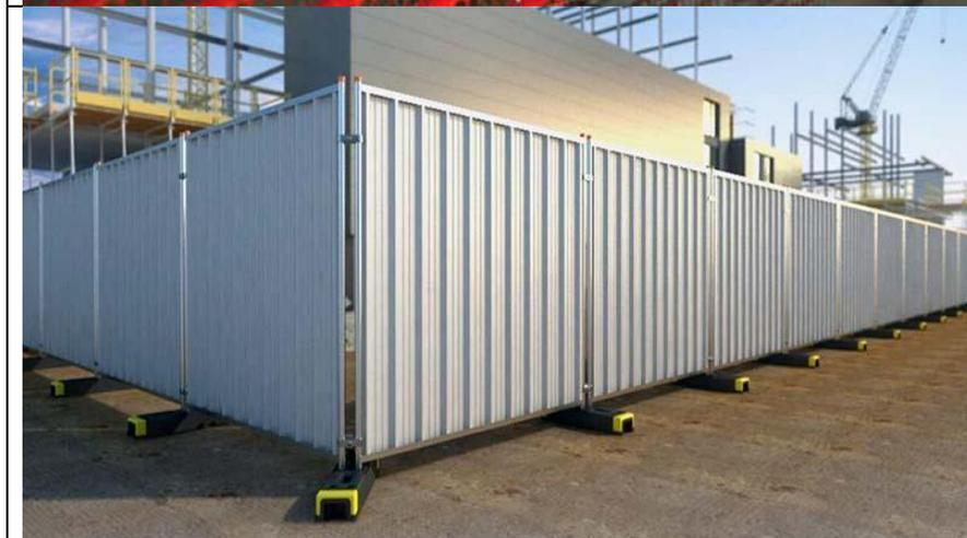
Открытая траншея должна ограждаться жестким ограждением (оцинкованным листом) высотой 1м, зона работы сварочным аппаратом и болгаркой должна ограждаться оцинкованным листом с 3 сторон высотой 2м
